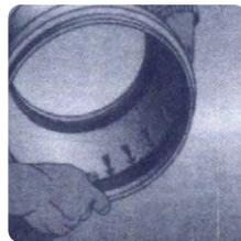
En la tubería de 600mm coloque el anillo de goma doblándolo en forma de corazón y asegúrelo en todo su contorno. En los tubos de 800mm y 1000mm fije el bisel a la espiga del tubo. Es recomendable colocar los biseles al sol para facilitar su instalación.
