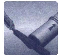
Si encuentra resistencia al acople, utilice una barra hincada como palanca contra un listón de madera. En los diámetros mayores será necesario utilizar la pala de la retroexcavadora, en dichos casos se debe proteger muy bien la campana de la tubería.
