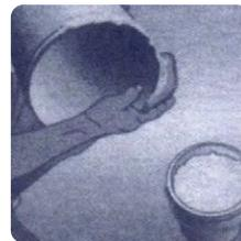
Para facilitar la unión aplique lubricante en la espiga (Solución jabonosa o grasa vegetal). El lubricante puede ser aplicado con la mano, un trapo o una estopa.
